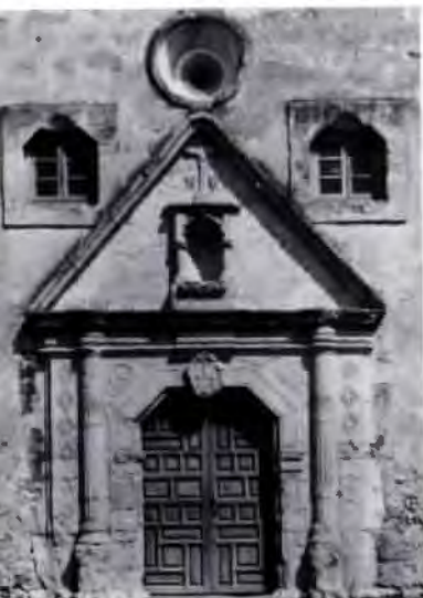
ABOVE: Nuestra Señora de la Purísima Concepción de Acuña, facade; OPPOSITE PAGE: Concepción, stairs to room above sacristy
