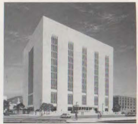
El Paso County Detention Facility, El Paso.
